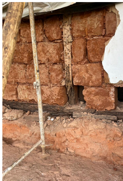
Fachada lateral esquerda, substituição dos esteios Autoria: Natália Morita Data: 10/04/2025
