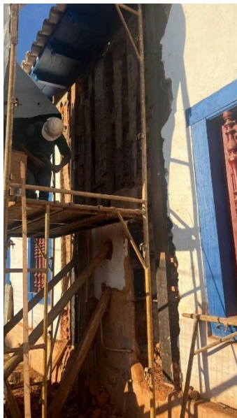
Recomposição de alvenaria da fachada posterior Autoria: Natália Morita Data: 10/04/2025
