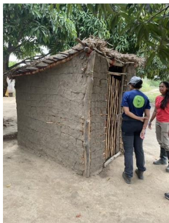
Casa de ferramentas. Autoria: Aline Bastos Data: 19/10/23
