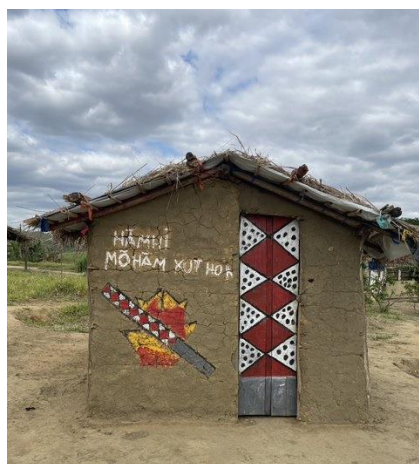
Casa de ferramentas. Autoria: Aline Bastos Data: 19/10/23
