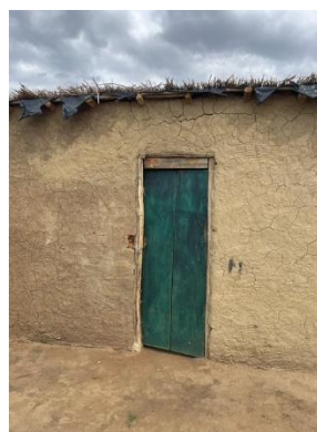
Casa de ferramentas. Autoria: Aline Bastos Data: 19/10/23
