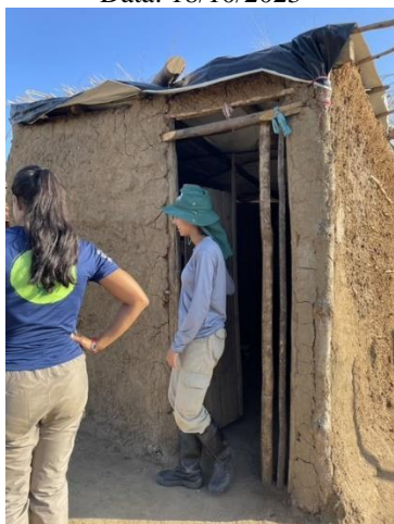
Casa de ferramentas. Autoria: Aline Bastos Data: 18/10/2023
