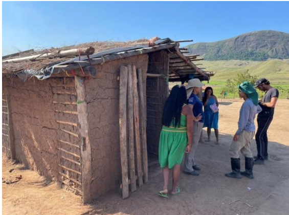
Casa de ferramentas. Autoria: Aline Bastos Data: 18/10/2023
