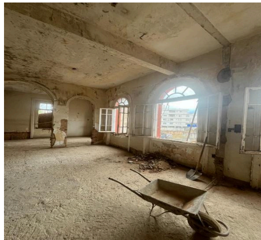
Segundo pavimento da edificação.
