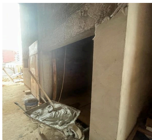
Fosso do elevador.
