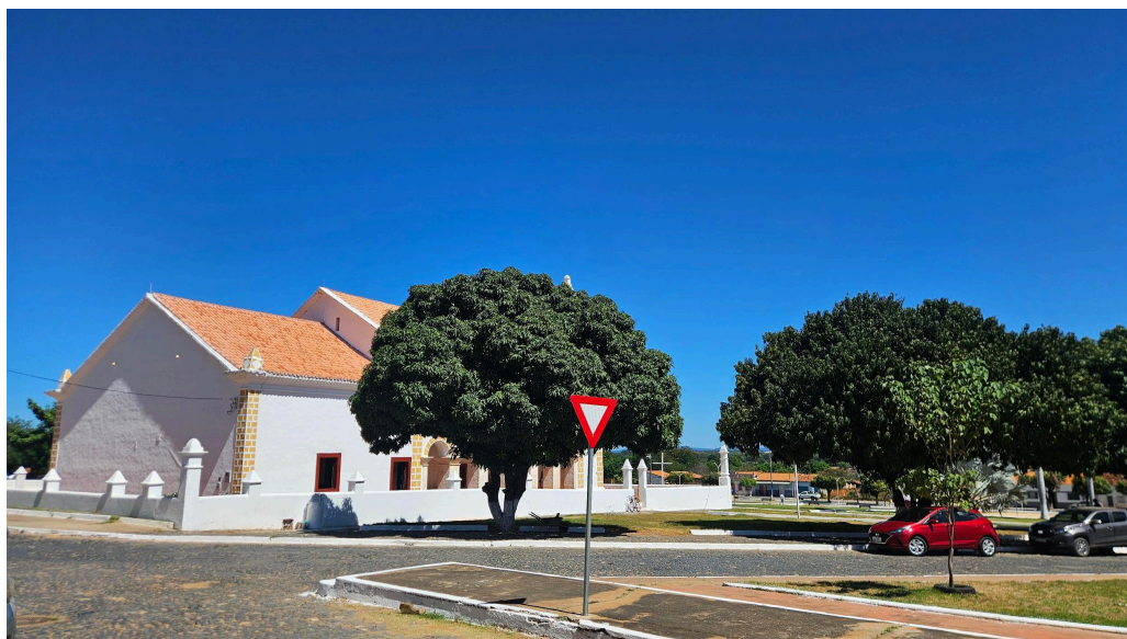
Vista dos fundos da igreja, com detalhe do telhado novo Autoria: Maria Leticia Ticle Data: 29/04/2026
