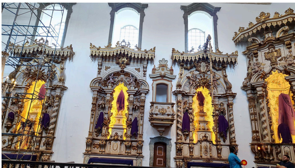
Iluminação dos retábulos colaterais da nave concluídas
