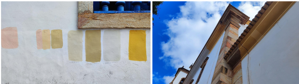
Teste de tonalidade da pintura mineral a ser aplicada nos elementos emoldurados (cimalha e enquadramentos) da fachada frontal Autoria: Francielle Ferreira Data: 10/03/2025
