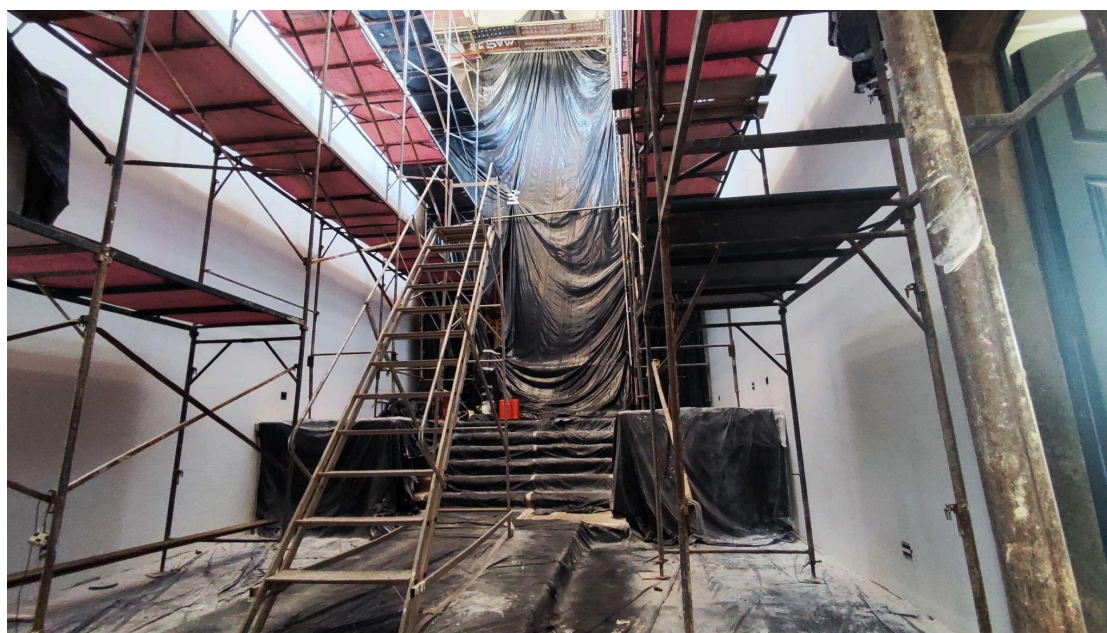
Pintura das alvenarias internas da capela mor em execução
