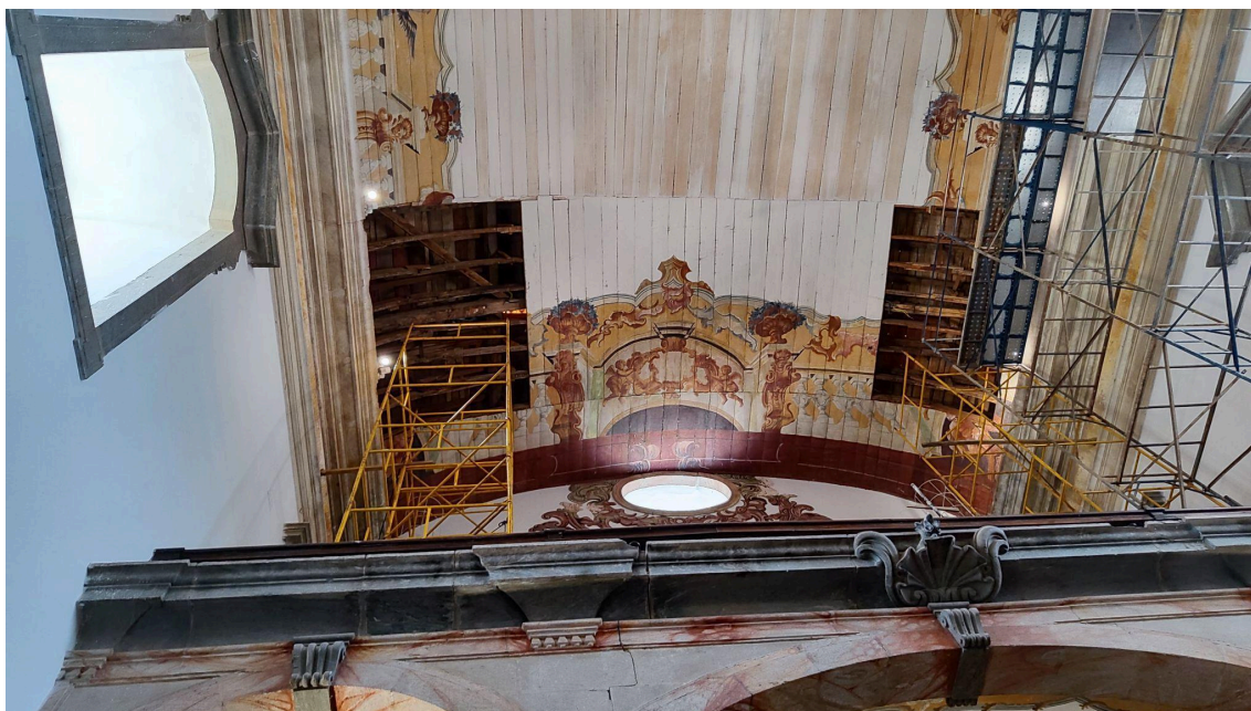
Restauração do forro da nave Autoria: Francielle Ferreira Data: 10/03/2025
