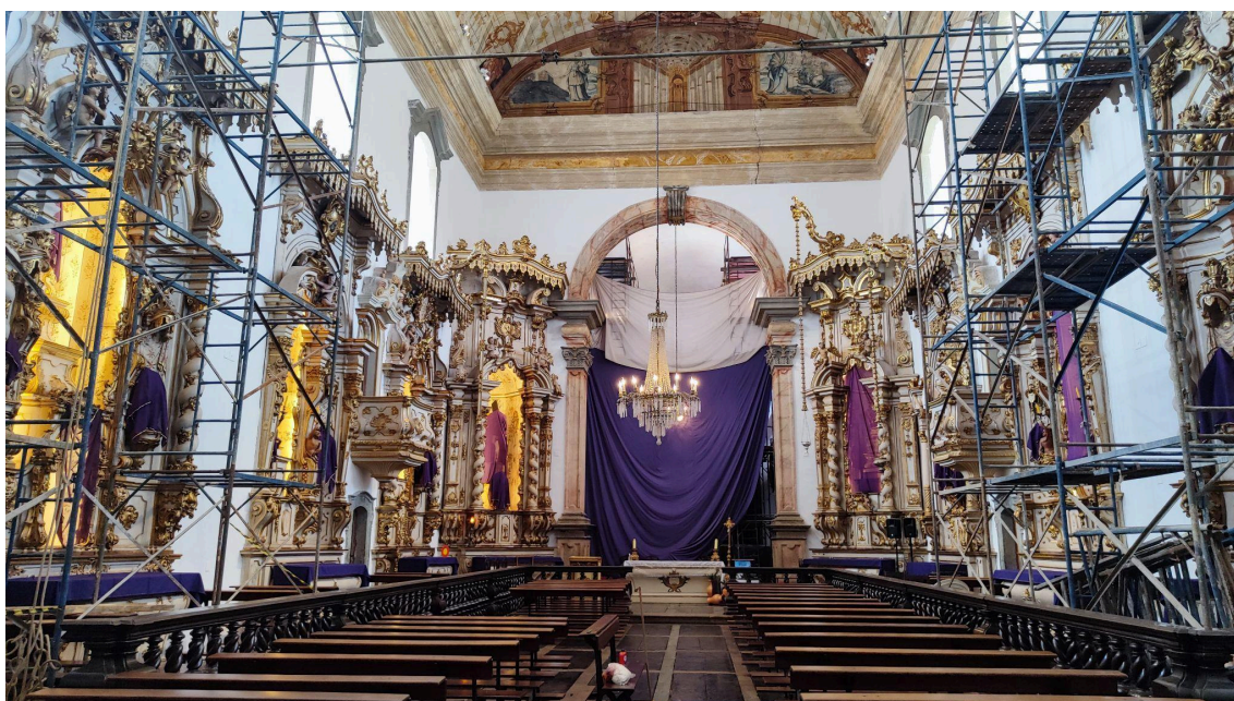
Iluminação e pintura da nave em avançado estágio de execução Autoria: Francielle Ferreira Data: 10/03/2025
