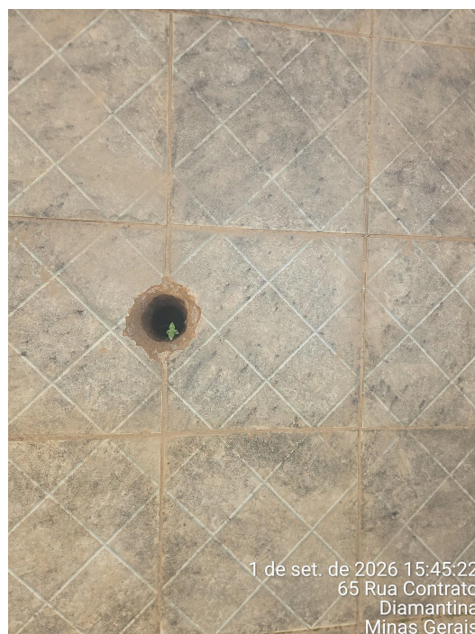
Imagem 6. Furo de sondagem no piso da área externa Autoria: Maria Letícia Ticle Data: 01/09/2026
