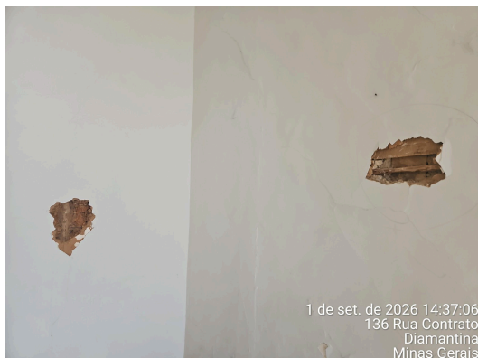
Imagem 3. Janelas de prospecção revelando técnicas construtivas da edificação Autoria: Maria Letícia Ticle Data: 01/09/2026
