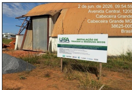
Placa sobre a obra em andamento.
