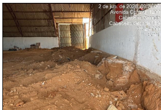
Área pendente para finalização da obra.
