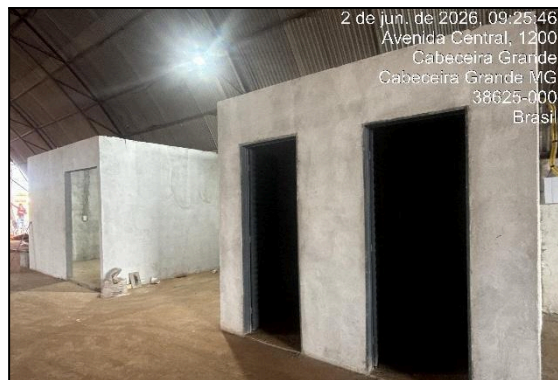
Áreas de cozinha e banheiro sendo implantadas. Autoria: Paula Grandi Data: 02/06/2026
