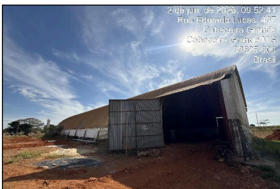
Galpão para a futura triagem de resíduos secos.
