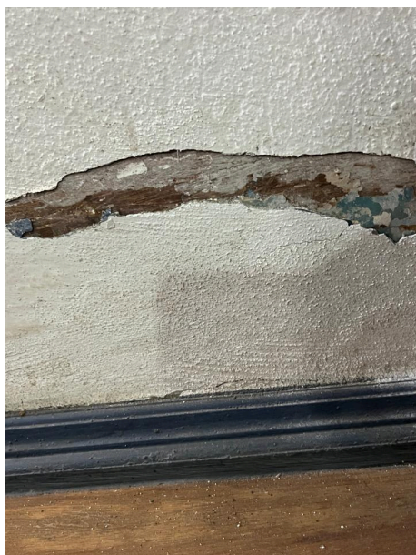
Prospecção de alvenaria e estrutura
