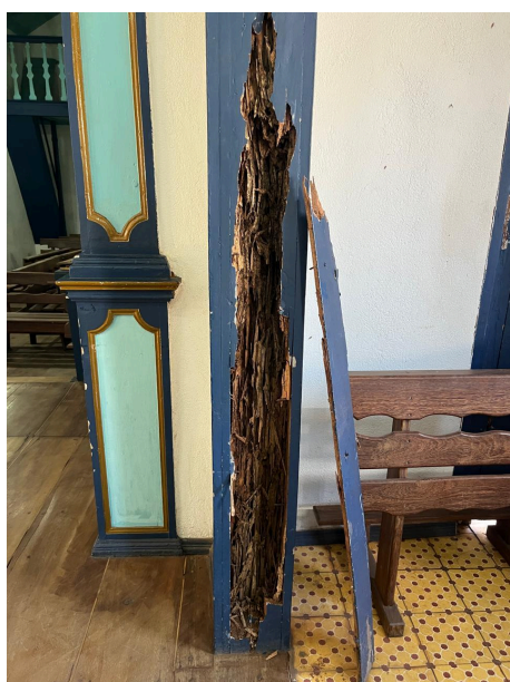
Prospecções da estrutura, ataque de insetos xilófagos
