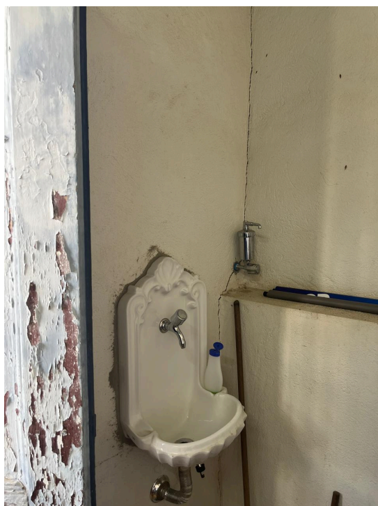
Pia e registro de água instalados no interior da Capela Data: 11/09/2026 Autoria: Natália Morita
