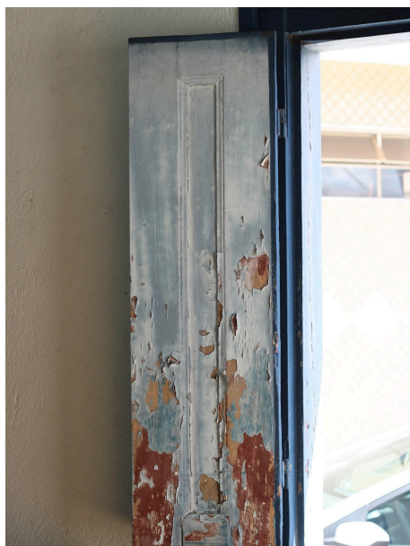
Folha da janela de abrir, fachada lateral direita da Capela
