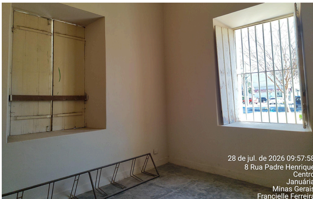
Recuperação de reboco das alvenarias, acabamento e pintura interna da edificação Autoria: Francielle Ferreira Data: 28/07/2026
