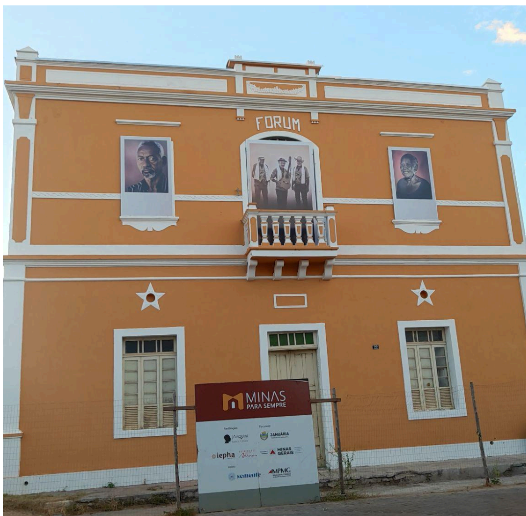
Obra finalizada - fachadas da edificação recuperadas Autoria: Francielle Ferreira Data: 28/07/2026
