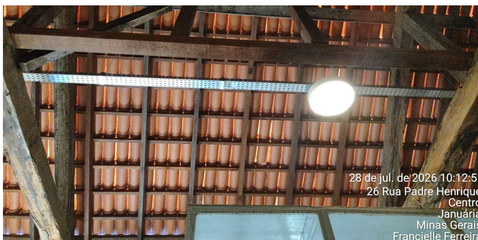
Cobertura da edificação restaurada e novo sistema elétrico instalado Autoria: Francielle Ferreira Data: 28/07/2026
