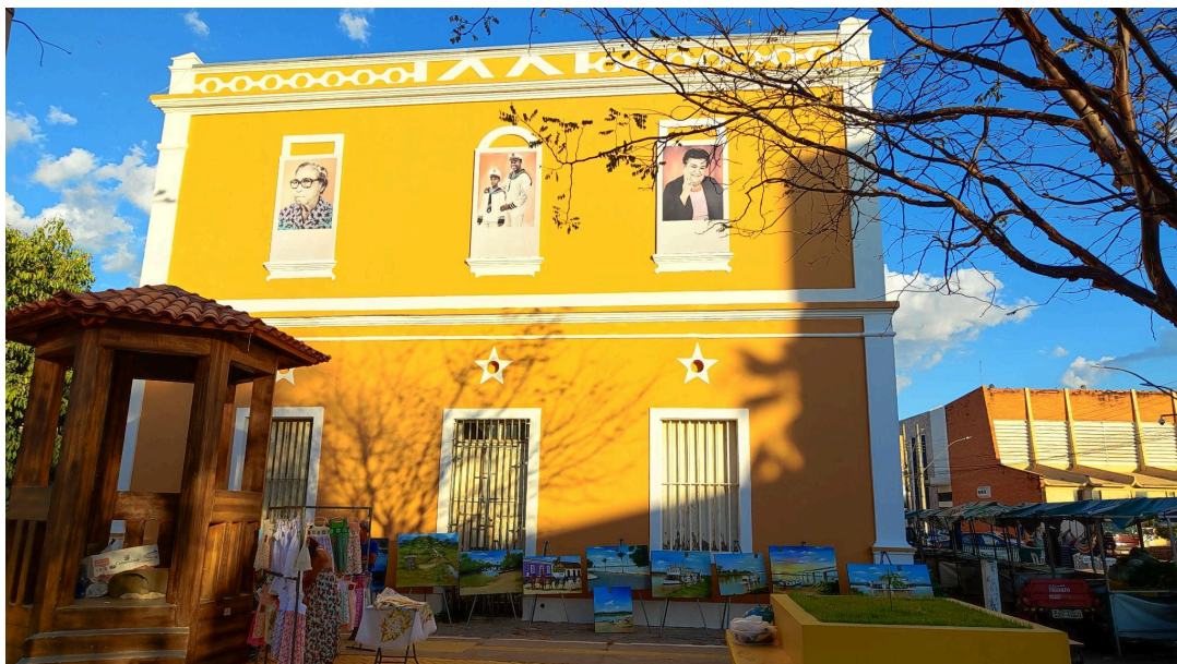
Obra finalizada e espaço externo em uso pela comunidade Autoria: Francielle Ferreira Data: 28/07/2026
