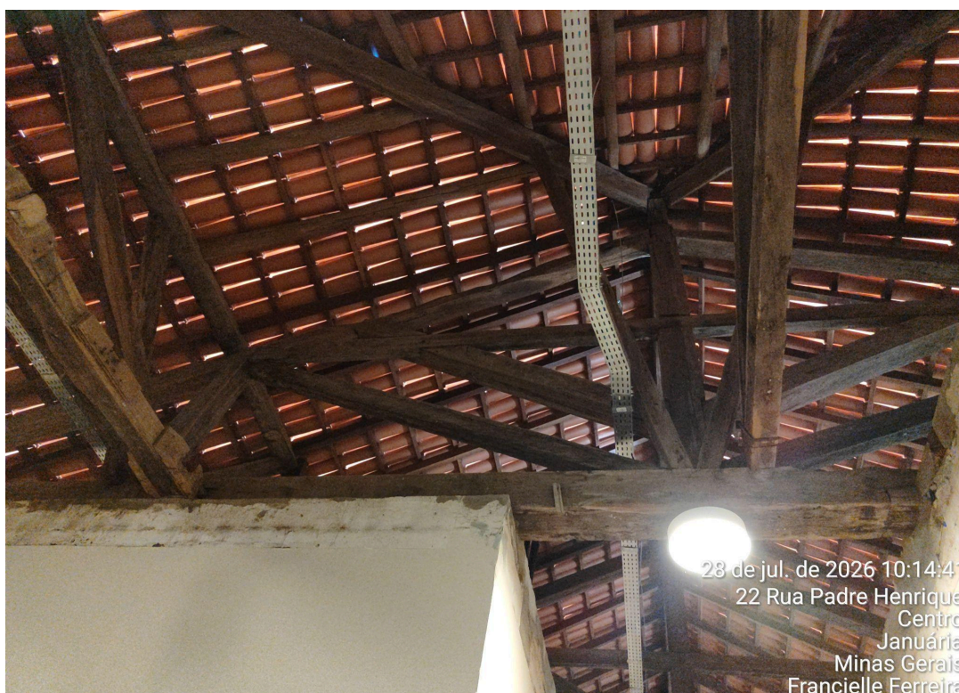
Cobertura da edificação restaurada e novo sistema elétrico instalado Autoria: Francielle Ferreira Data: 28/07/2026
