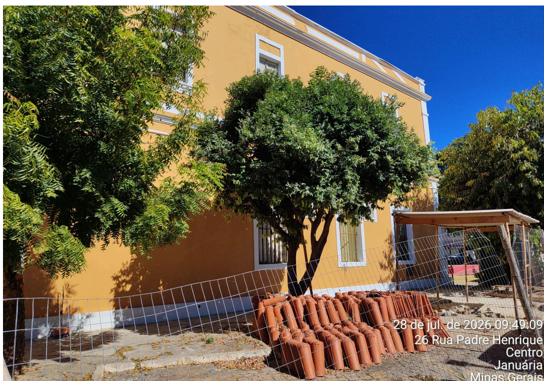
Canteiro de obras - desmobilização Autoria: Francielle Ferreira Data: 28/07/2026
