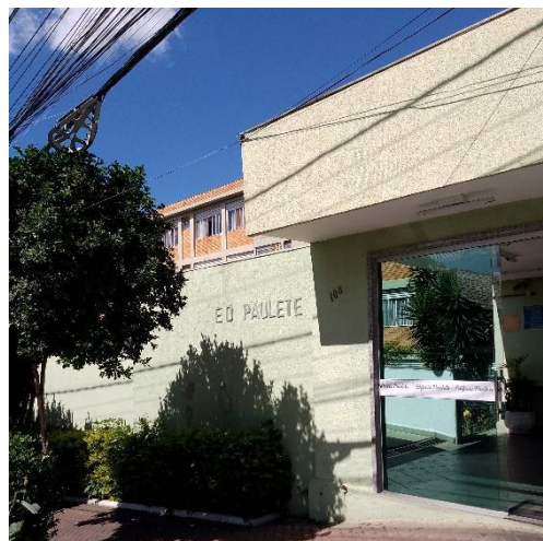
Entrada do prédio da moradia da Márcia Pereira. Autoria: Eduardo Santos Data: 29/04/2024
