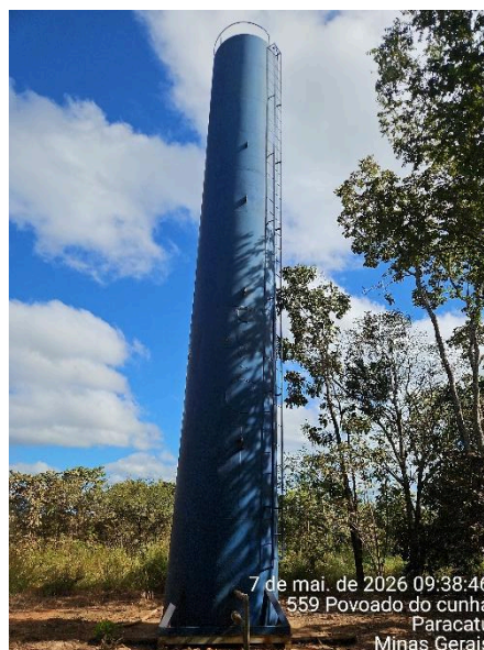
Imagem 4. Caixa d'água reformada Autoria: Carolina Rodrigues Bordignon Data: 07/05/2026
