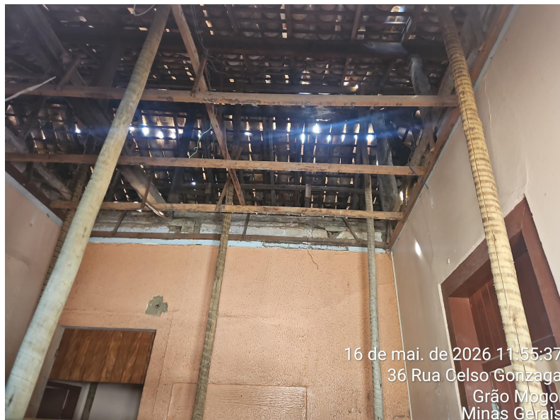
Imagem 2. Interior da edificação com escoras Autoria: Maria Letícia Ticle Data: 16/06/2026
