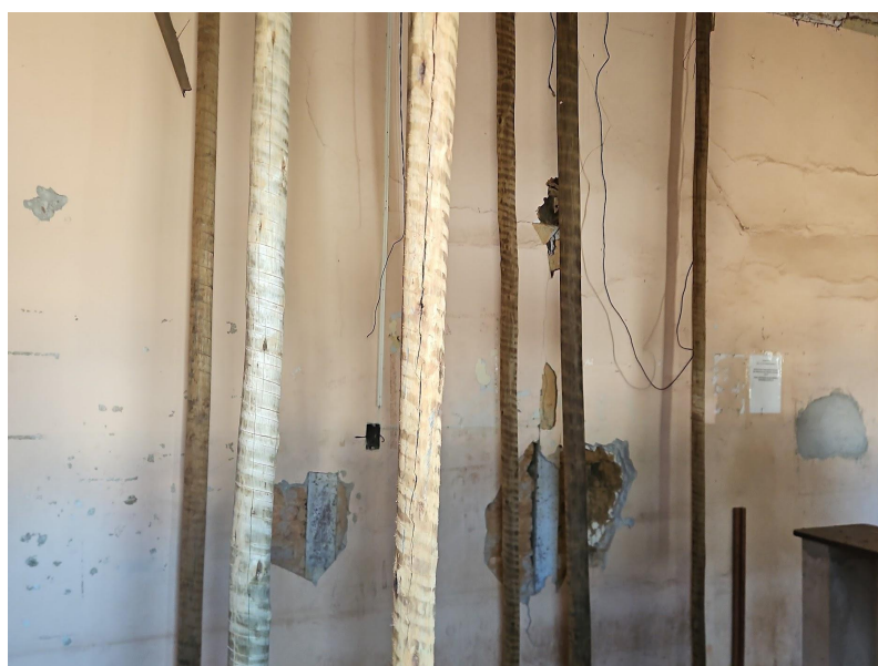
Imagem 3. Interior da edificação com escoras Autoria: Maria Letícia Ticle Data: 16/06/2026
