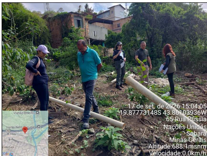
Passivo sanitário em área das intervenções do projeto Autoria: Instituto Plantando Data: 17/09/2026
