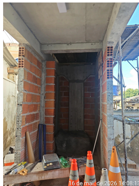
Imagem 7. orre para instalação da plataforma de elevação - vista interna Autoria: Maria Letícia Ticle Data: 16/06/2026
