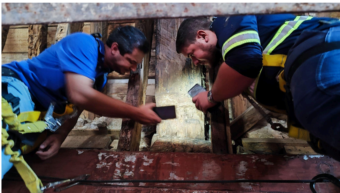
Inspeção realizada pelo arquiteto responsável pela proponente e o representante da empresa responsável pela execução dos serviços. Autoria: Francielle Ferreira Data: 27/11/2024
