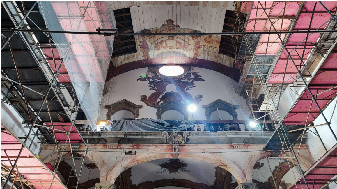
Restauração do forro da nave Autoria: Francielle Ferreira Data: 27/11/2024
