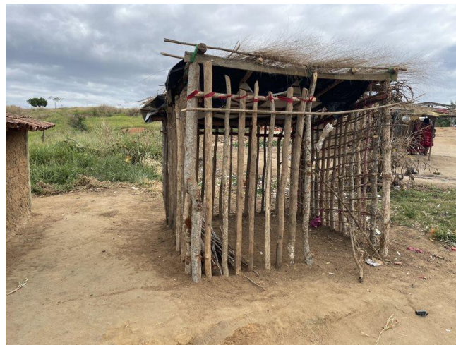
44a. Casa de ferramentas do Antônio Marcos.
