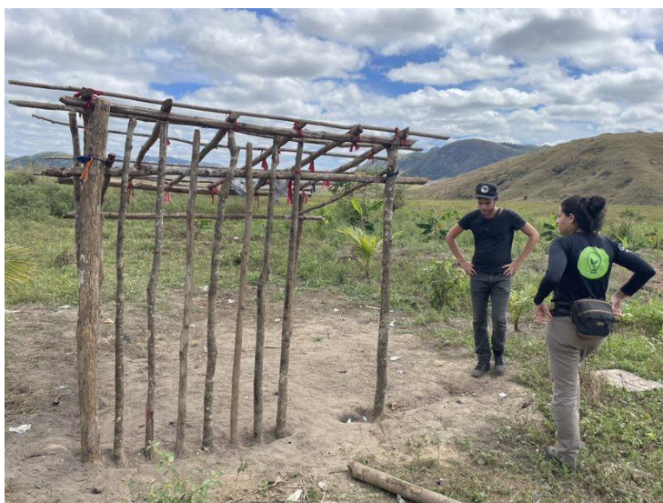
39a. Casa do Laurindo no início de sua construção.
