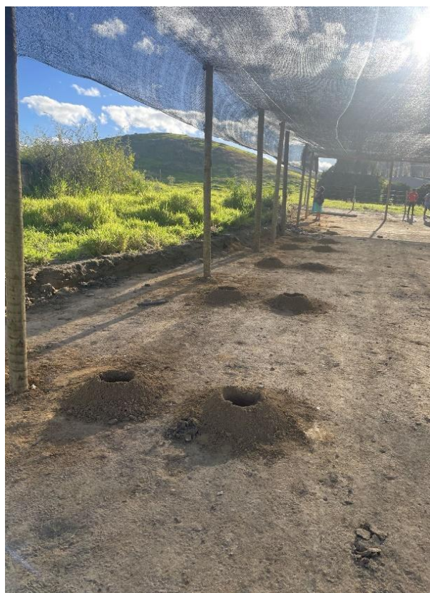
8. Perfurações para construção da bancada do viveiro de mudas.
