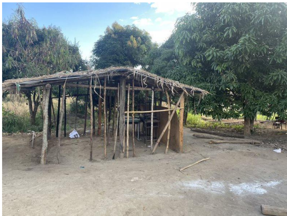
26. Casa de ferramentas do Jussuel em construção na Aldeia do Tarsílio.
