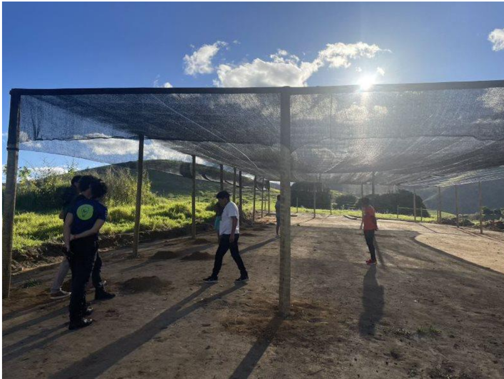
7.a Área coberta do viveiro de Água Boa em construção.
