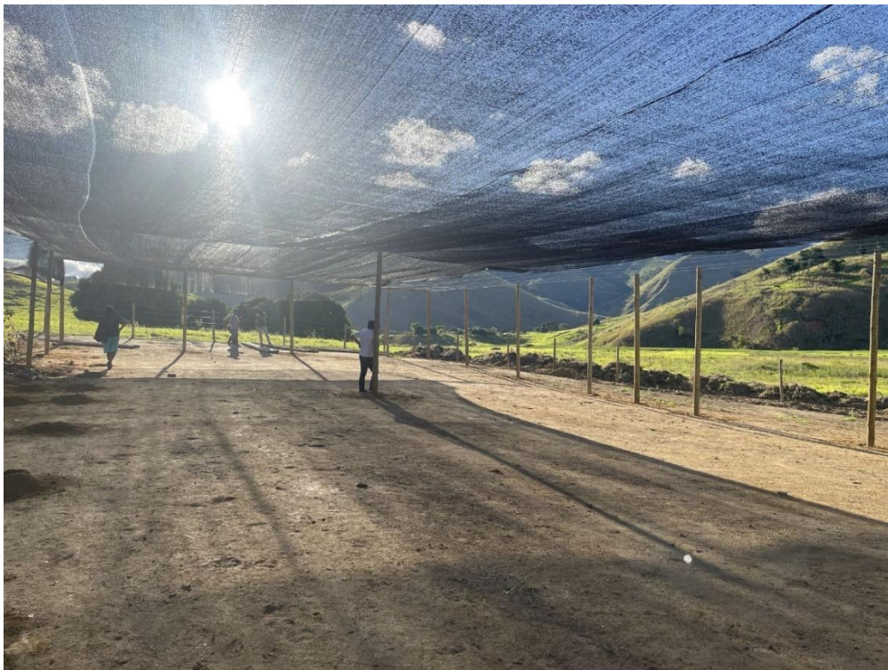
7.b Área coberta do viveiro de Água Boa em construção.
