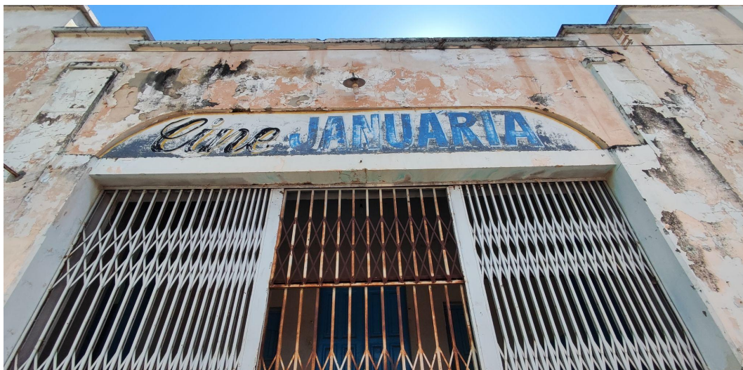
Estado de conservação da fachada do Cine Januária
