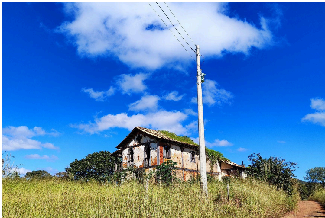
Execução da extensão da rede de energia - pendente de ligação do padrão CEMIG Autoria: Francielle Ferreira Data: 07/05/2026
